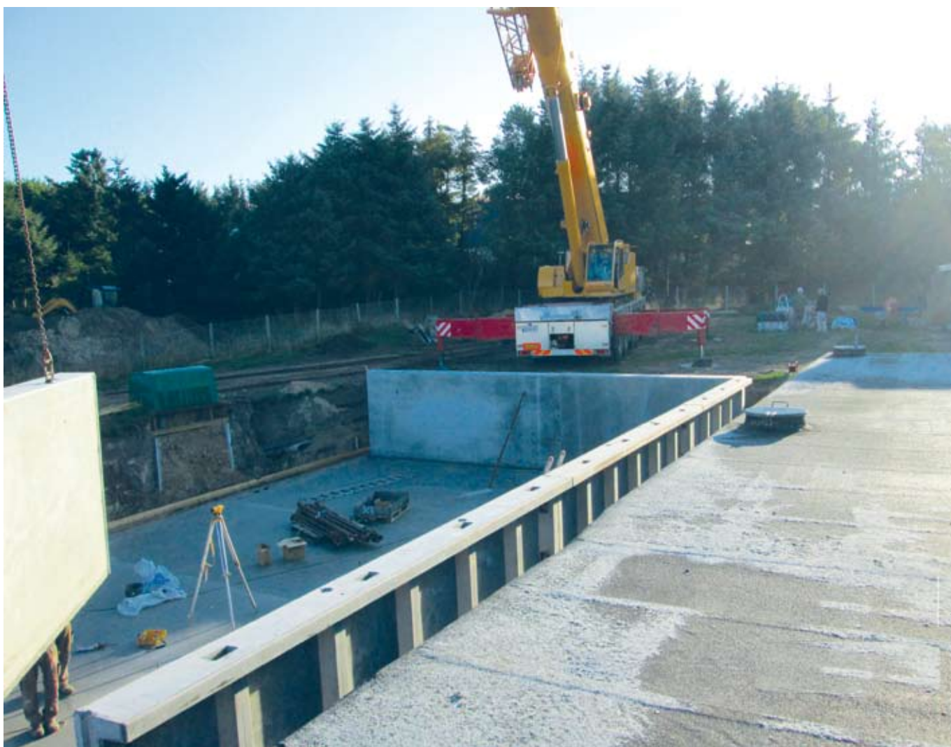
Bygningen af en ny rentvandstank på 500 m 3 , 2013
